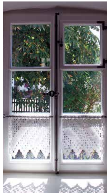
Für die Neuanfertigung eines historischen Fensters mit alten Beschlägen in einem Bauernhaus in Werschweiler hat die Firma Reiner Kiefer aus Remmesweiler 2012 den „Bundespreis für Handwerk in der Denkmalpflege“ erhalten.
