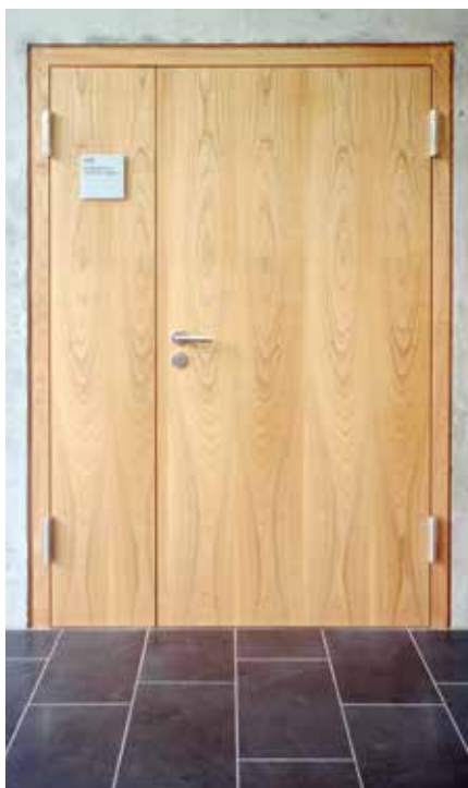
Ein Türflügel dieser feuerhemmenden T90-Tür wiegt 240 Kilogramm und ist aus Kirschbaumfurnier gefertigt. Verbaut wurde sie von der Schreinerei Hero am Sprachforschungszentrum der Saar-Uni in Saarbrücken.
