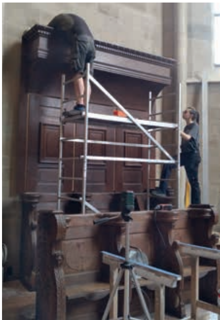
Mitarbeiter von Ames Holzbearbeitung bei der Arbeit am neuen Chorgestühl in der Abtei St. Mauritius in Tholey.
